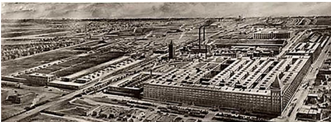
Hình 3.5. Nhà máy điện Hawthorne
