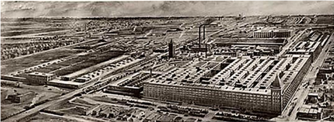
Hình 3.5. Nhà máy điện Hawthorne
